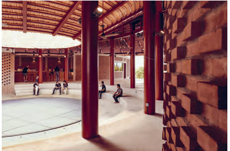
Zum Schutz vor Überschwemmungen wurde die kreisförmige Struktur leicht erhöht gebaut. Das Wasserbecken in ihrem Zentrum lässt sich abgedeckt auch als Bühne nutzen.
