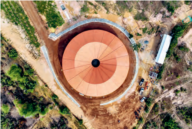
Zum Schutz vor Überschwemmungen wurde die kreisförmige Struktur leicht erhöht gebaut. Das Wasserbecken in ihrem Zentrum lässt sich abgedeckt auch als Bühne nutzen.
